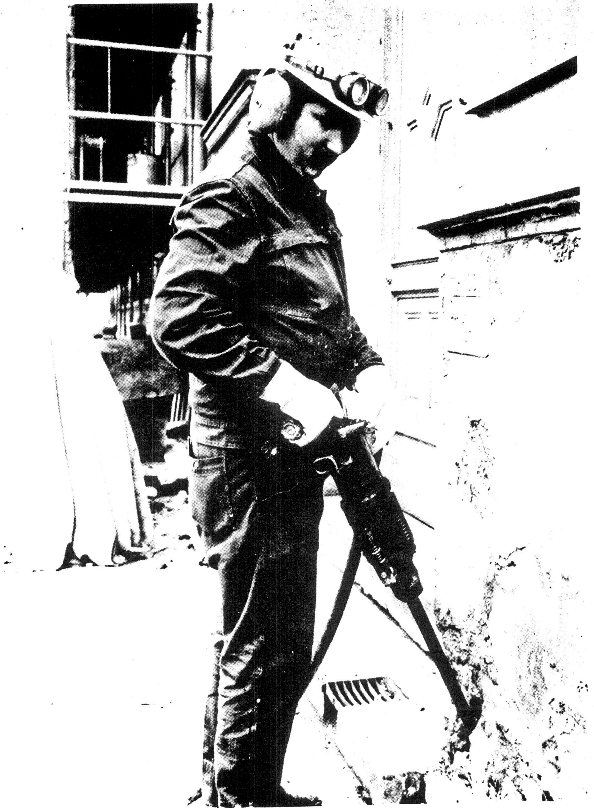
ایجاد سوراخهایی در دیوار مرطوب از بالا به پایین بمنظور میله گذاری و خشکانیدن بنا
